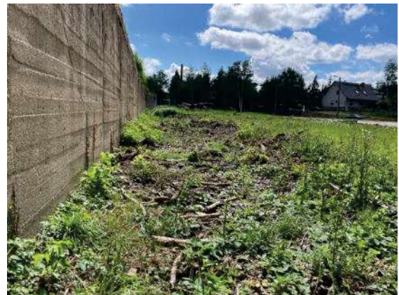
Foto 44: Bereich westlich des Bauwerkes altes Gleis
