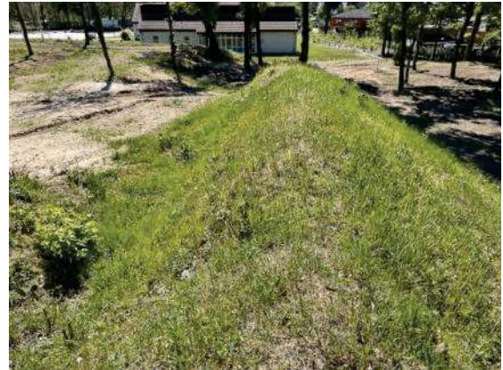
Foto 22: Blick von der Dammkrone Erdhaufen Süden
