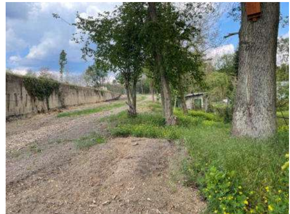
Foto 28: Bereich östlich des Bauwerkes Bewuchs zur Grundstücksgrenze
