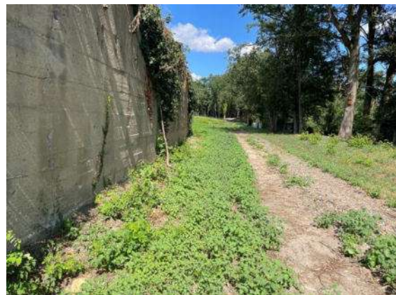
Foto 58: Bereich östlich des Bauwerkes altes Gleis, Blick nach Norden
