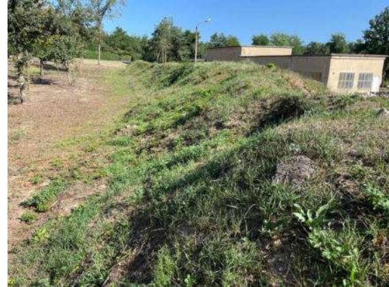
Foto 86: Zustand Erdhaufen mit geringem Bewuchs
