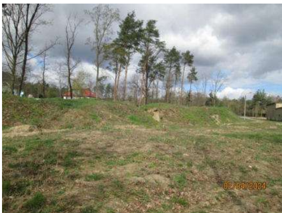
Foto 9: Ansicht der Erdhaufen von Süden
