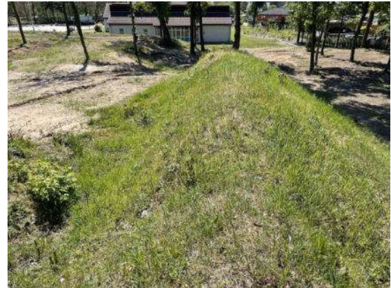
Foto 22: Blick von der Dammkrone Erdhaufen Süden
