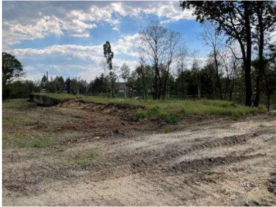
Foto 37: Blick zum ehemaligen Bahngleis auf dem Bauwerk
