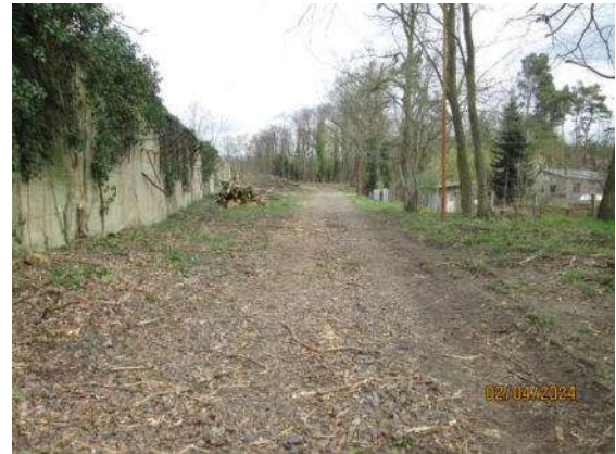
Foto 2: Bereich östlich des Bauwerkes altes Gleis
