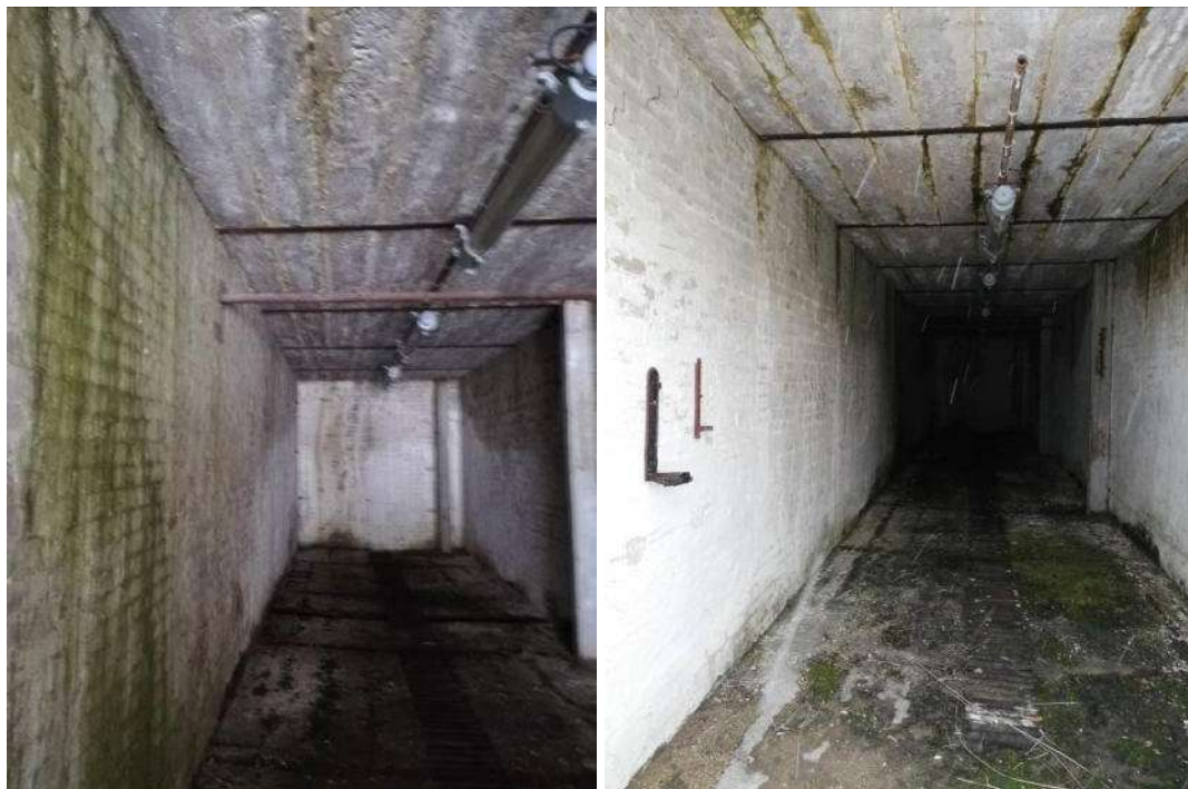
Abbildung 9: Gebäude im Zentrum, Innenansicht
