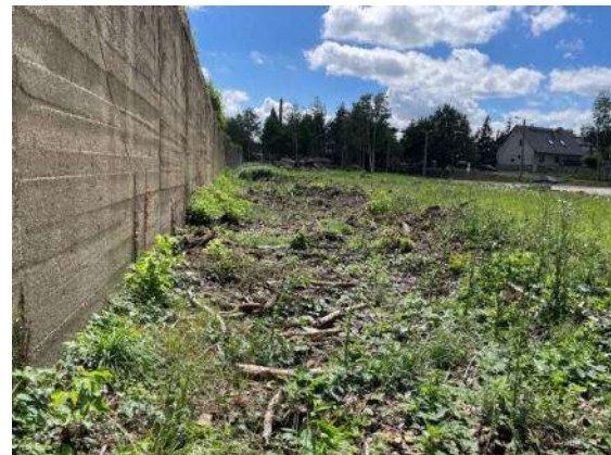
Foto 44: Bereich westlich des Bauwerkes altes Gleis
