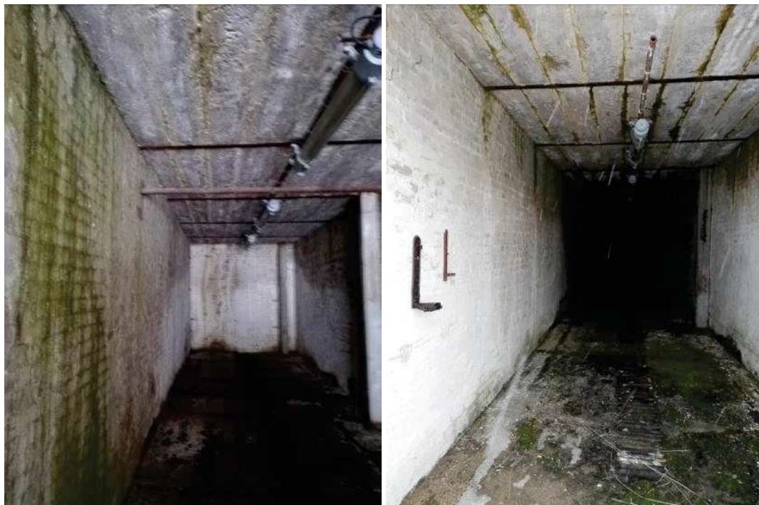
Abbildung 9: Gebäude im Zentrum, Innenansicht
