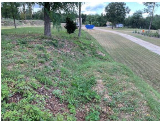
Foto 75: südliche Böschung, Blick nach Norden
