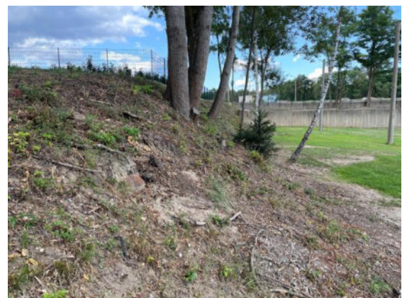
Foto 76: Böschung östlich Lutzweg
