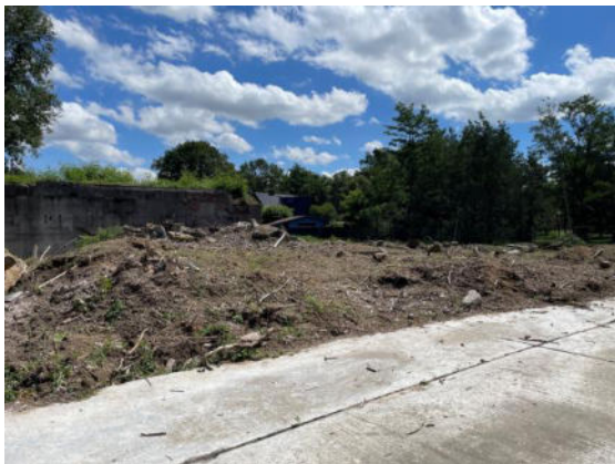
Foto 43: südliche Flächen vor dem Bauwerk Bahngleis
