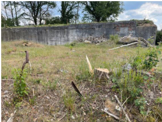
Foto 27: südliche Fläche mit Blick zum ehem. Gleis auf dem Bauwerk
