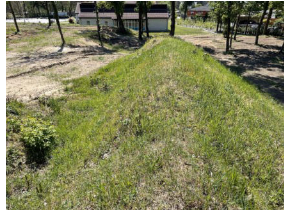
Foto 22: Blick von der Dammkrone Erdhaufen Süden
