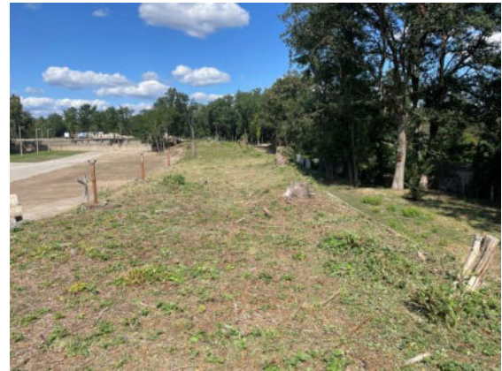
Foto 60: Flächen Bahngleis vollständig abgemäht, Blick nach Norden
