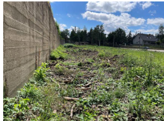
Foto 44: Bereich westlich des Bauwerkes altes Gleis
