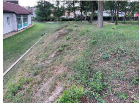
Foto 74: südliche Böschung (an allen Begehungstagen ohne Funde)
