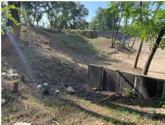
Foto 81: Flächen nordwestlich des Bahngleises, Blick nach Süden
