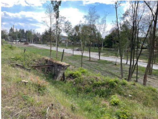
Foto 39: Blick auf die südliche Waldfläche vom Bauwerk aus
