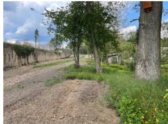
Foto 28: Bereich östlich des Bauwerkes Bewuchs zur Grundstücksgrenze
