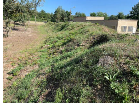
Foto 86: Zustand Erdhaufen mit geringem Bewuchs
