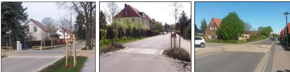
**Abb. 19:** Beispiele für geschwindigkeitsdämpfende Maßnahmen im Nebennetz
