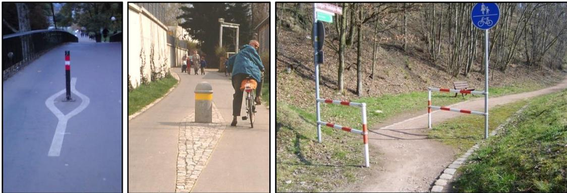
**Abb. 28** Beispiele für die Reduzierung von Konfliktpotenzialen an Pollern / Umlaufsperrern
