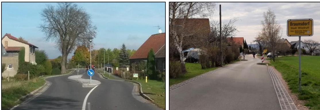
**Abb. 27** Beispiele Ortseingangsgestaltung mit Fahrstreifenversatz bzw. Fahrbahneinengung
