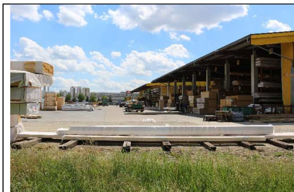
Foto 1: Blick über die Betriebsfläche nach Süden. Lebensraum für Gebäudebrüter (Haussperling, Hausrotschwanz, Bachstelze)
